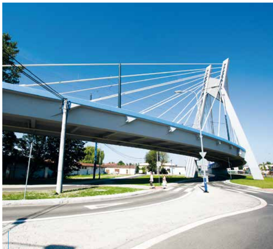
Nowa estakada tramwajowa łącząca ulice Lipską i Wielicką ma długość 2,19 km
